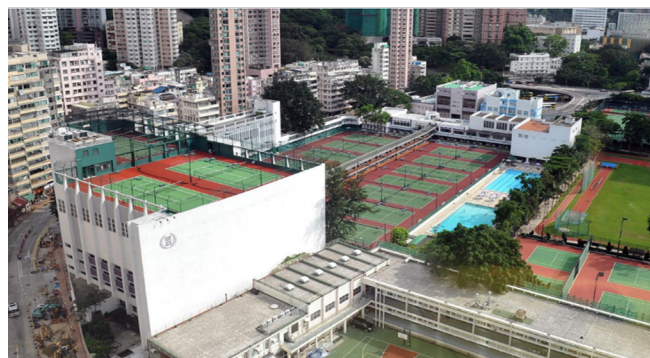
Figura 2. Pistas de tenis construidas en la azotea del edificio. Club recreativo chino, Hong Kong.
